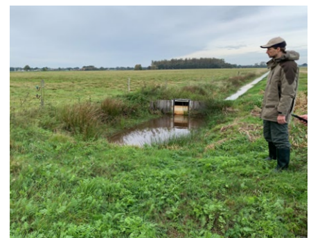
Stauanlage in der Diepholzer Moorniederung. Foto: NLWKN
